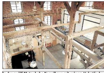
In das zwölf Meter hohe Kesselhaus mit seinem Holzständerwerk wurden zwei Ebenen für Büros und Probenräume eingebaut. RN-FOTO BANDERMANN
